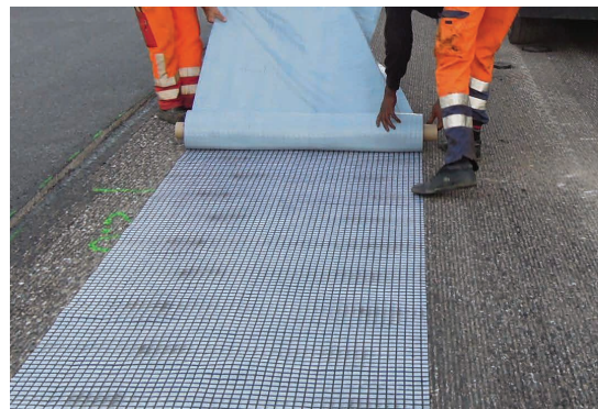
Рис. 2: Укладка сетки ADFORS GlasGrid PG для локальной санации
