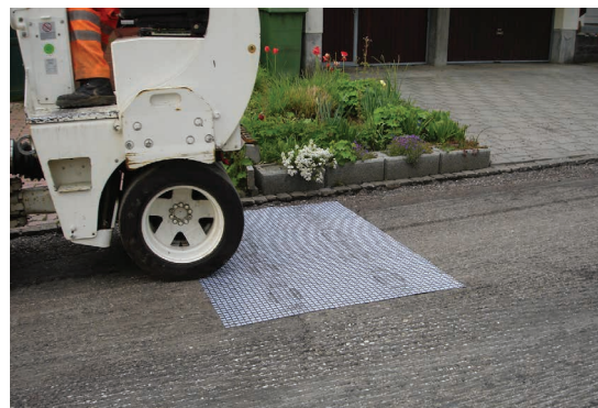
Рис. 3: Укладка сетки ADFORS GlasGrid PG для локальной санации и активации адгезионного компонента
