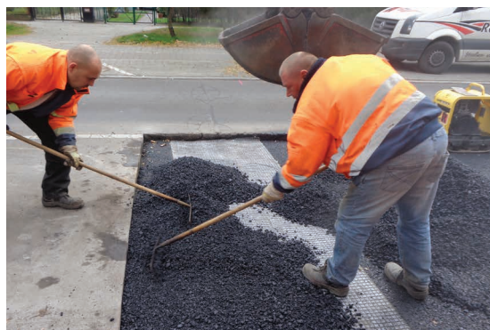
Рис. 9: Укладка асфальтового слоя на решетку ADFORS GlasGrid PG
