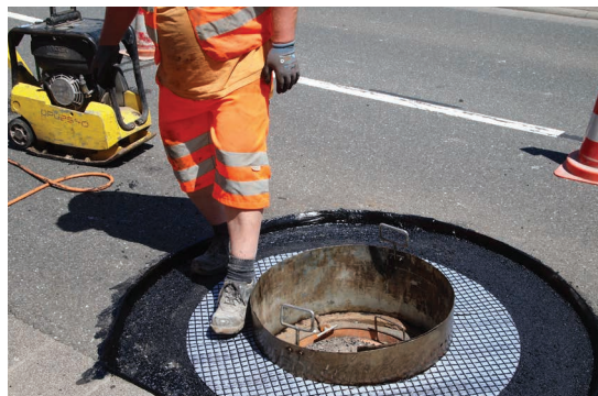
Рис. 4: Укладка сетки ADFORS GlasGrid PM для защиты колодцев
