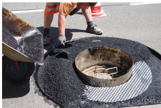
Рис. 8: Укладка асфальтового слоя на решетку ADFORS GlasGrid PM
