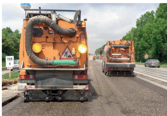
Рис. 1: Высоконапорная технология для чистки поверхности
