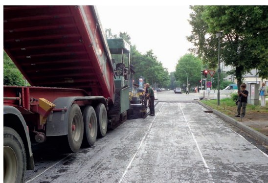
Рис. 9: Укладка асфальтового слоя на геокompозит ADFORS GlasGrid CGL
