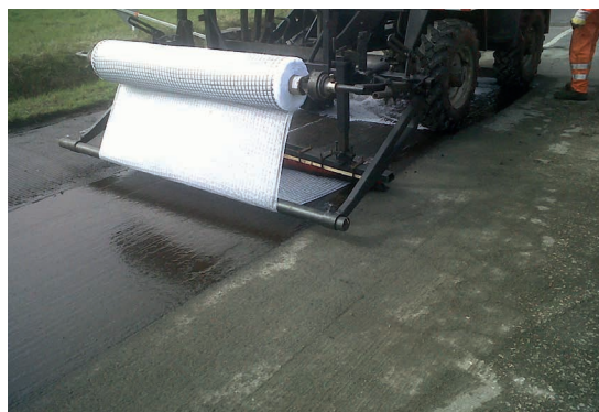
Рис. 4: Укладка сетки ADFORS GlasGrid CGL передвижным устройством
