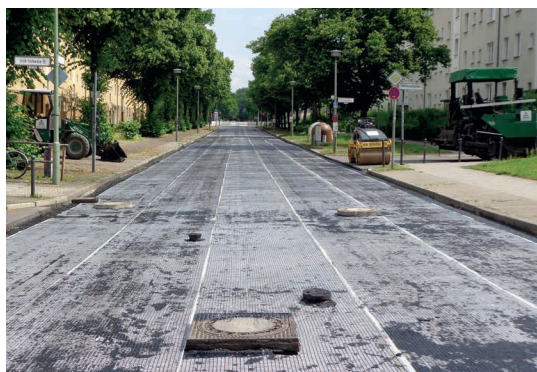
Рис. 2: Типичная укладка геосетки ADFORS GlasGrid CG/CGL на фрезерованную поверхность
