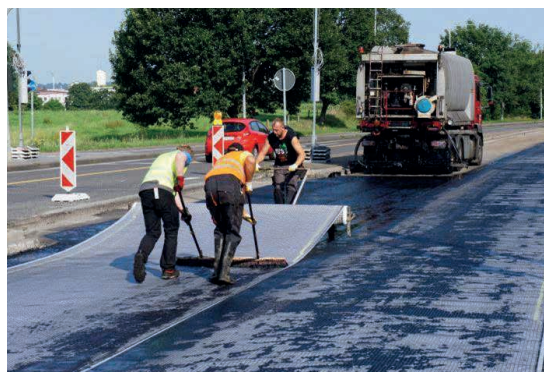
Рис. 5: Ручная укладка сетки ADFORS GlasGrid CGL
