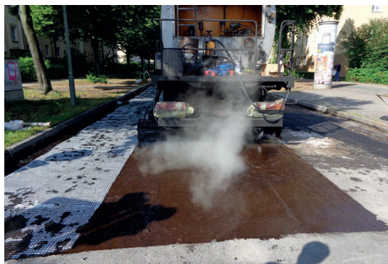
Рис. 3: Применение соединительной эмульсии перед укладкой геокомпозита ADFORS GlasGrid CGL
