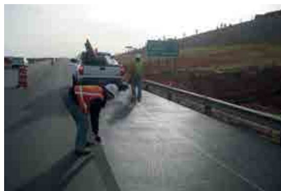
Рис. 4: Ручная укладка сетки ADFORS GlasGrid
