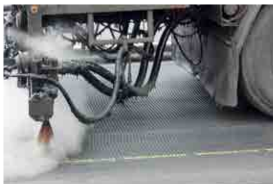
Рис. 8: Применение соединительного напыления на сетку ADFORS GlasGrid GG
