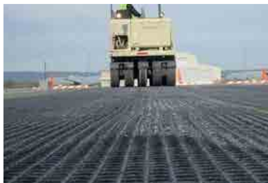
Рис. 2: Укладка и активация клея на выравнивающем слое
