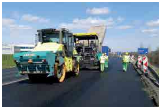
Рис. 9: Укладка асфальтового слоя
