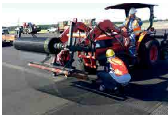
Рис. 3: Укладка сетки ADFORS GlasGrid передвижным устройством
